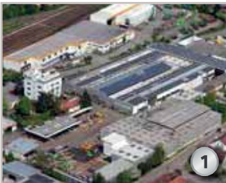
Works 1, Straubing: Company headquarter Werk 1, Straubing: Unternehmenssitz
